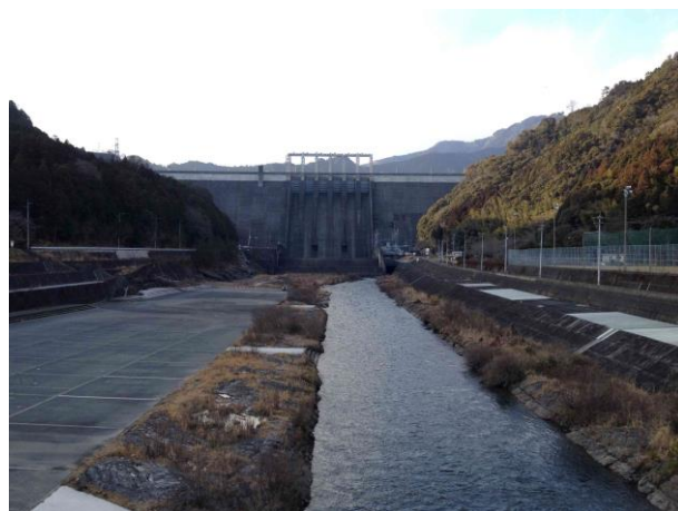
写真 21 夕暮れの早明浦ダム
