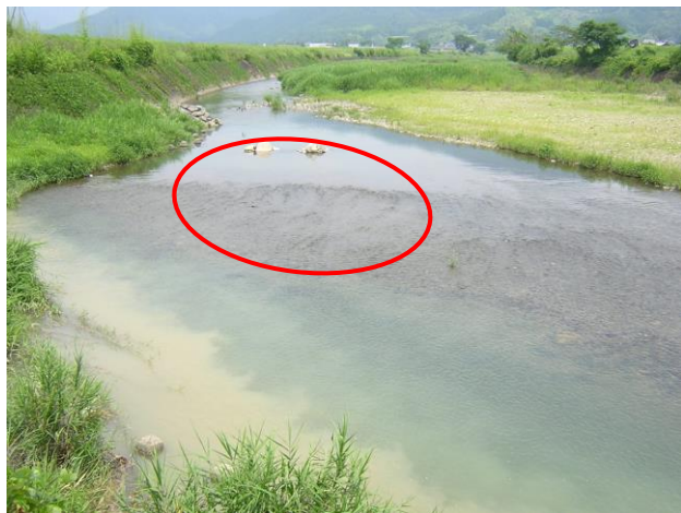
Fig.4 中央部の hidrobarrier dam (石 2 個) で出水時に土砂を流去させる(熊本県菊池川水系岩野川, 2009)
