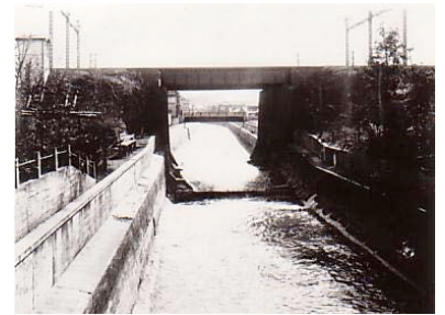
Fig. 5 昭和10年の神田川（整備後）
