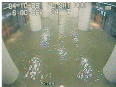
Fig.26 平成 16 年 10 月麻布十番駅 地下ホーム冠水状況
